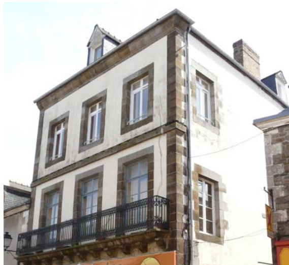
L'enduit met en relief l'architecture des encadrements et tout le dessin de pierre de taille.
