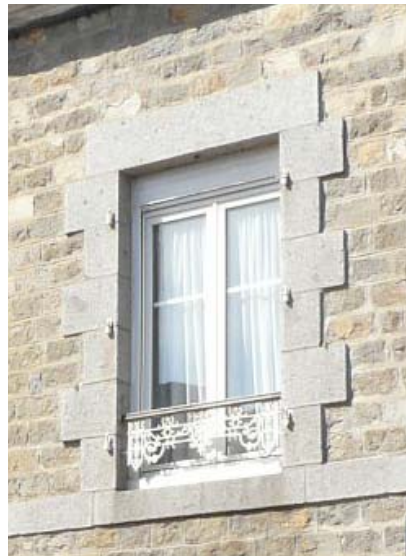
NON Fenêtre PVC avec petits bois intérieurs
